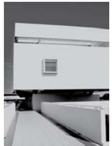
Vistas de la doble fachada al oeste. Es la sección más desfavorable del edificio, debido a ello se colocó un muro que evita el calentamiento del edificio de las 12 del día a las 6 de la tarde, funciona como bloqueador solar y da protección de la radiación durante todo el año, además de tener una expresión gráfica de líneas de tensión entre los elementos sólidos y los vacíos.
