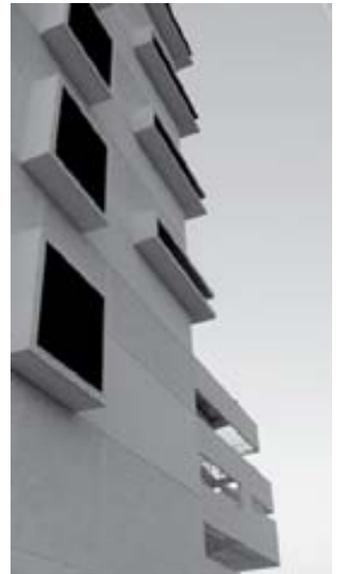
El edificio de la segunda etapa de la Escuela de Medicina, dialoga tipológicamente con los demás edificios de su entorno, dispuesto en el sentido longitudinal del terreno se conecta con el puente peatonal al edificio ovalado y resuelve el aspecto bioclimático gracias a la posición y a su geometría lineal de grandes aleros y permitiendo el paso transversal del aire.
